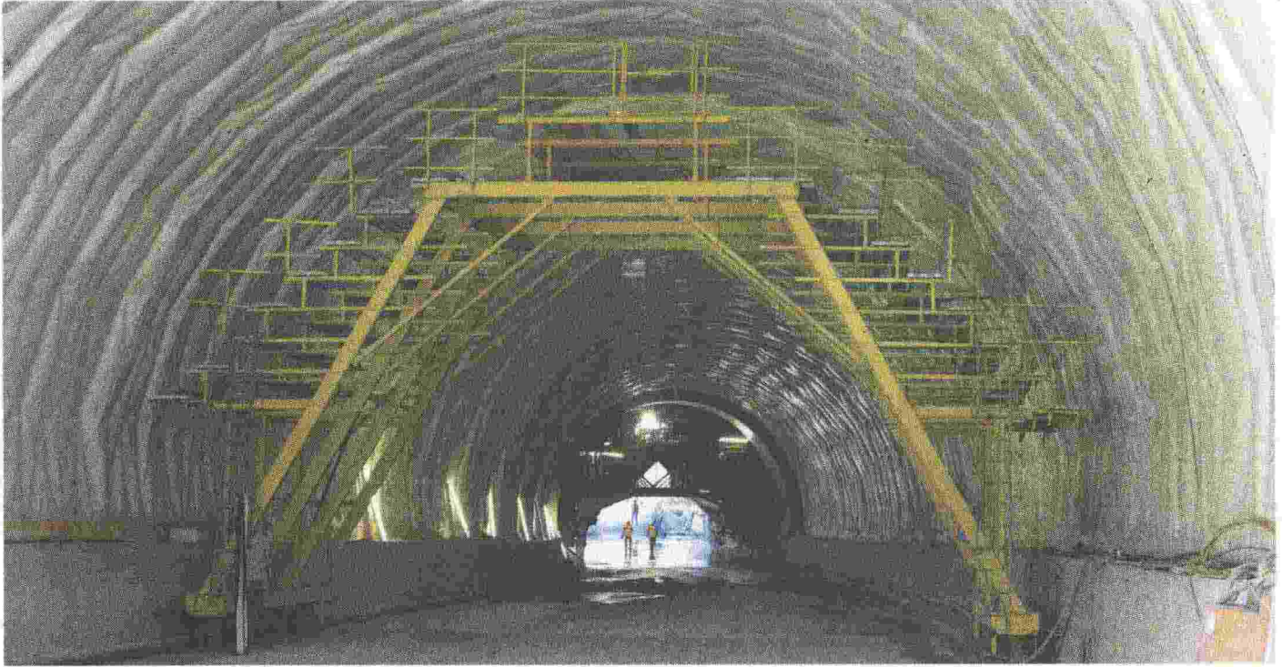
LA GALLERIA Il traforo realizzato a Borzoli per la strada di cantiere propedeutica al Terzo Valico
